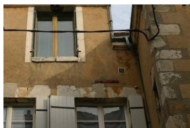
Enduit à la chaux et pierre de taille
