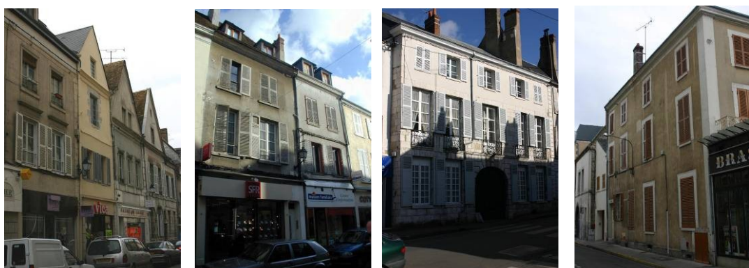
Maisons à boutique et maisons de ville à deux étages, avec ou sans comble
