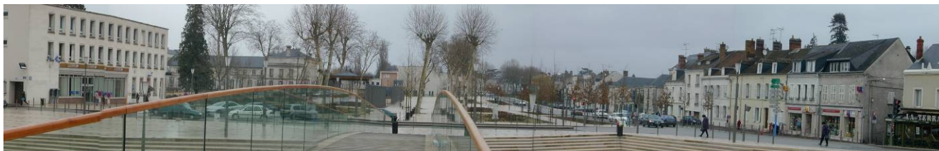
La nouvelle passerelle piétonne, à l'ouest du pont Saint Nicolas
