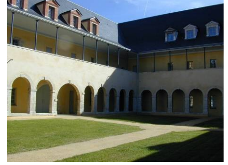
Les Ursulines, ancien hôpital transformé en logements
