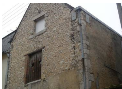
Maçonnerie de moellon hourdé au mortier de chaux
